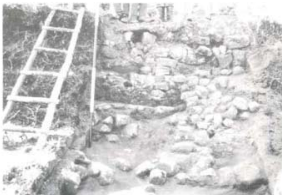
Fig. 9. Samaipata, sector 4, trinchera 1, muro de contención, visto de sur a norte. Foto: P.I.A.S. 1992.
