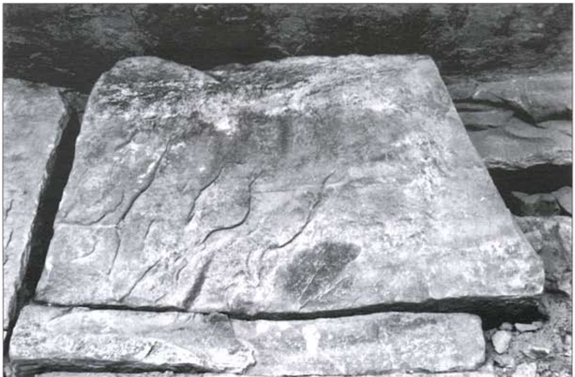
Foto 7.b: después del tratamiento.
