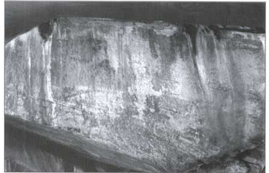
Foto 3.b.: después de la limpieza.
