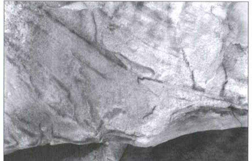
Foto 4.b.: después de la limpieza.
