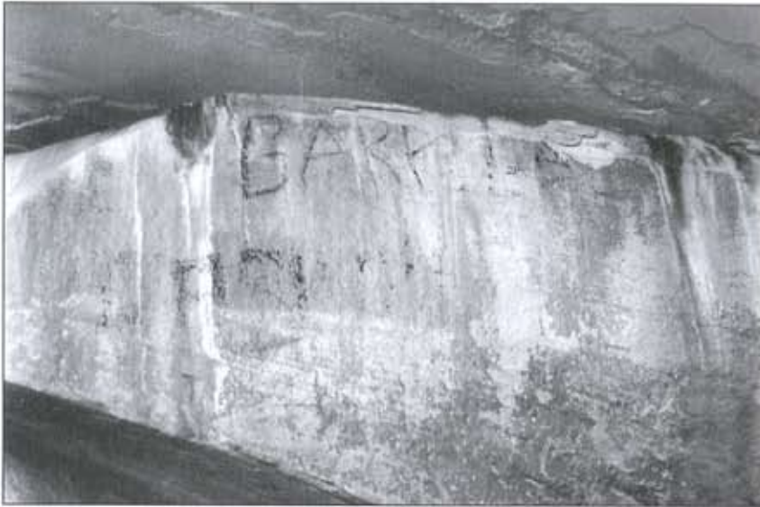
Foto 3.a: antes de la limpieza. Graffiti: GARREAL CARDON; material: carbón; tratamiento: brocha suave en medio húmedo (agua destilada).
