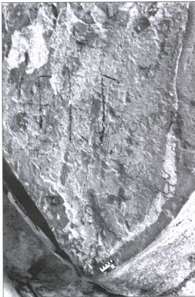
Foto 2.a: antes de la limpieza. Graffiti: FEC RANON DA LOS 1983; material: carbón; tratamiento: brocha suave en medio húmedo (agua destilada).
