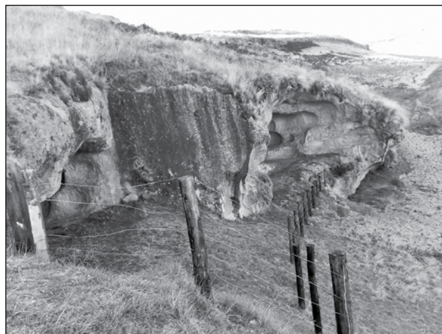
Fig. 23: Cerco con alambres de púa instalado frente a las cuevas en 2017 por el Ministerio de Cultura (foto: cortesía Sisko Rendón, nov. 2018).
